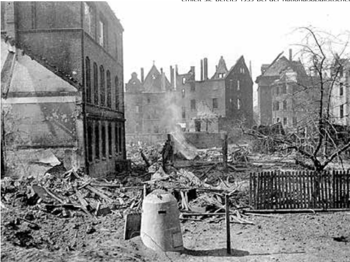
Zerstörung am Oerweg; im Vordergrund ein Ein-Mann-Splitterbunker (Foto: Stadtarchiv)
